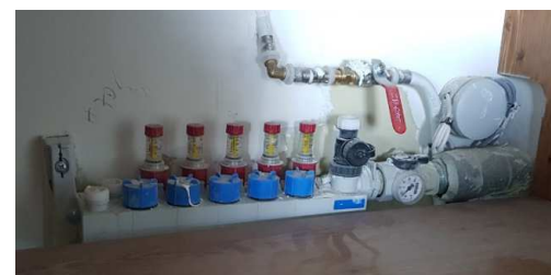
Vannes de régulation installées dans les classes
